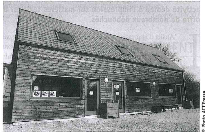
A Ambricourt, la toiture du Gerموir devrait accueillir 50 m 2 de panneaux photovoltaïques.
