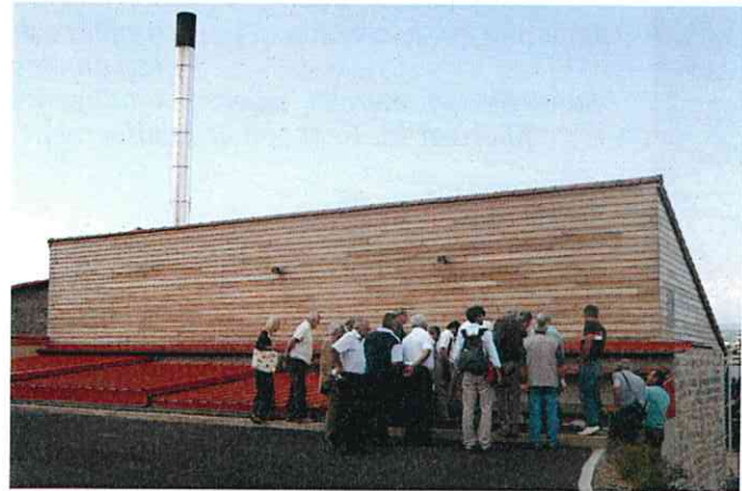
Visite d'une chaufferie (Source : CCI 48-30)
