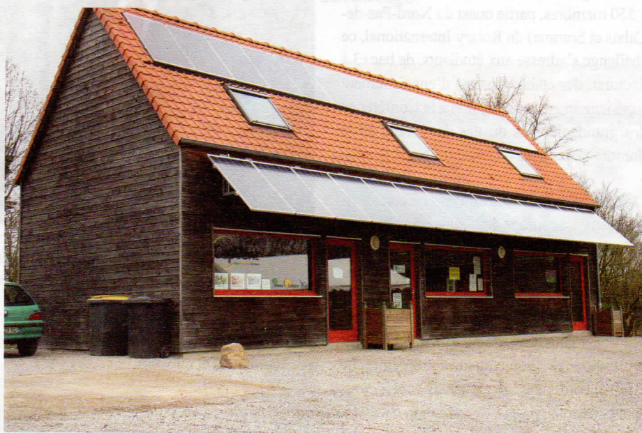
Le bâtiment du Gerموir équipé des panneaux photovoltaïques.
